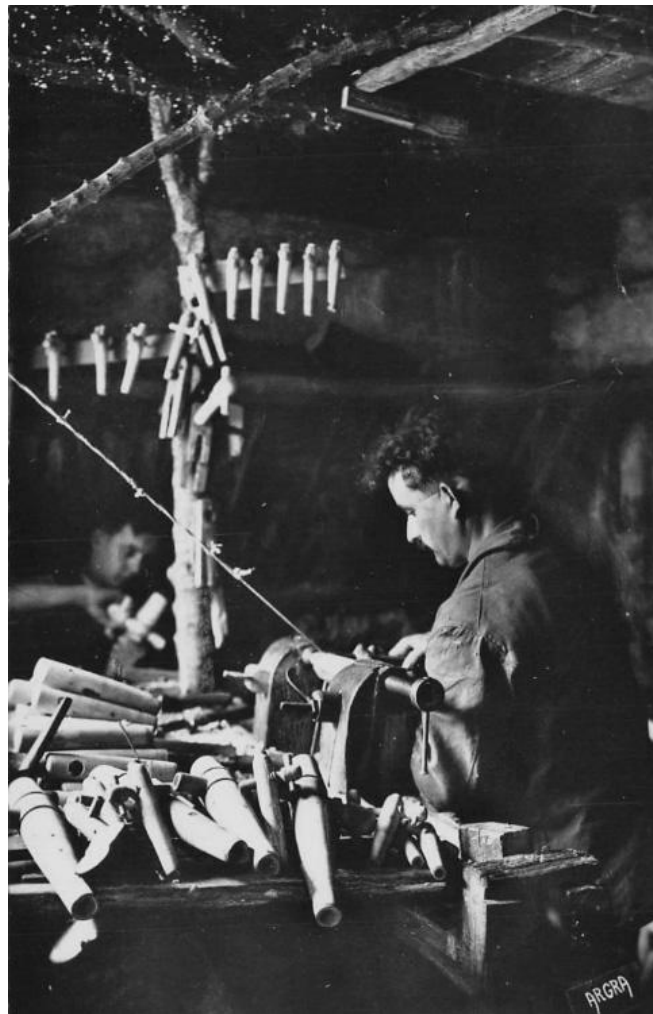
Figure 4 – carte postale ancienne : atelier de fabricant de robinet en bois : noter en haut du cliché la perche du tour
